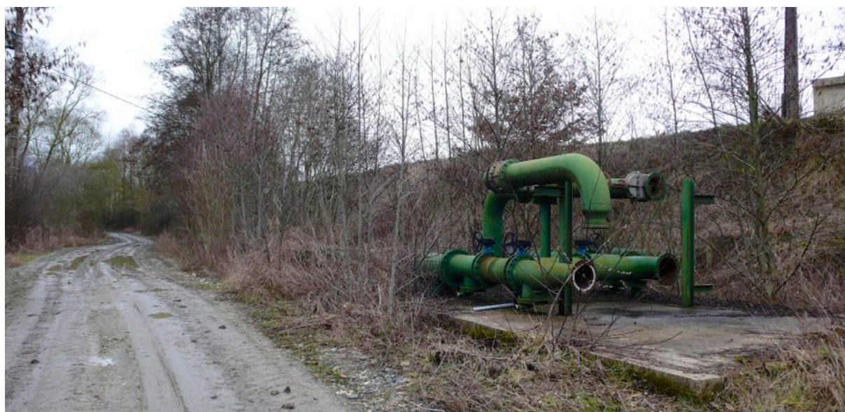
Un bassin à Saint-Germainmont ; restes du réseau hydraulique utilisé lors du process industriel.
