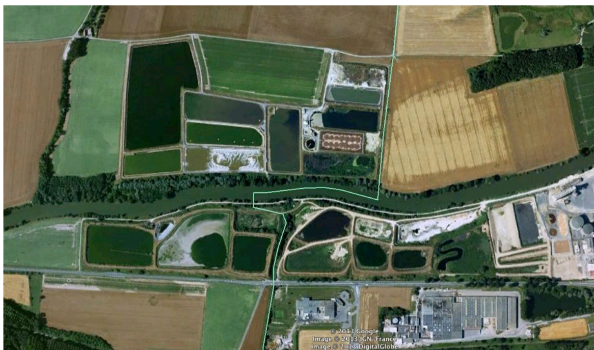
Secteur de Montigny-Lengrain, Courtioux, Vic-sur-Aisne.
