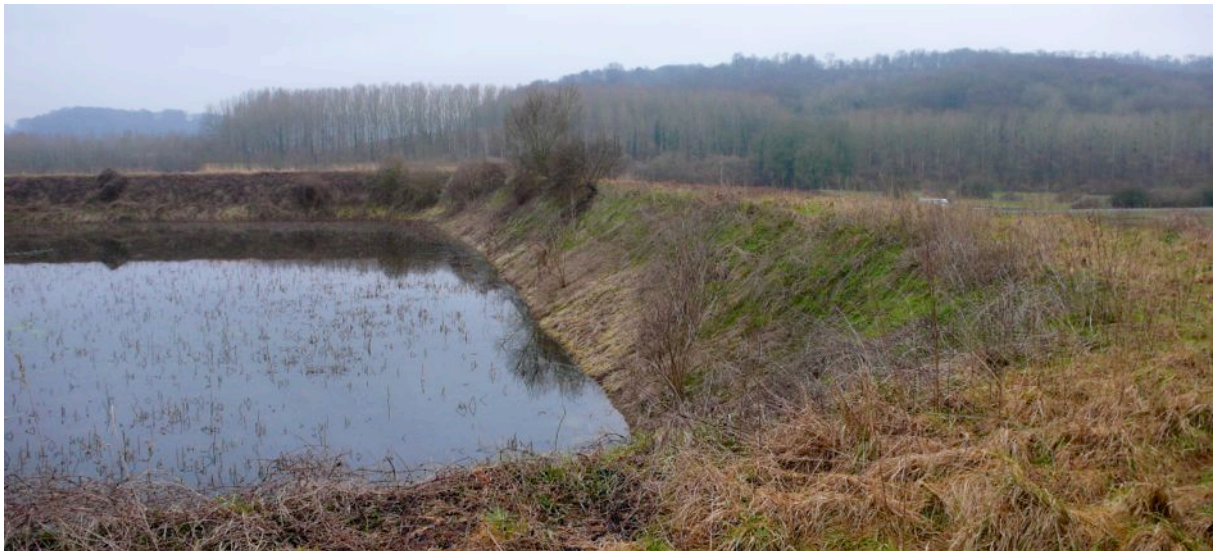
Bassin de Montigny-Lengrain, rempli de terre à environ 50%.
